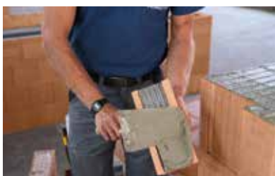
Anmörteln der Anschlagsschale.
