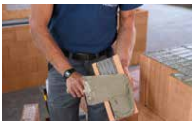
Anmörteln der Anschlagsschale.
