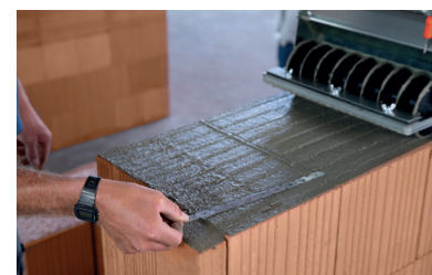
Ggf. zusätzliche Lagesicherung mit Flachstahllanker.
