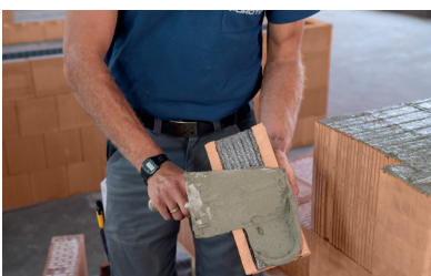
Anmörteln der Anschlagschale.
