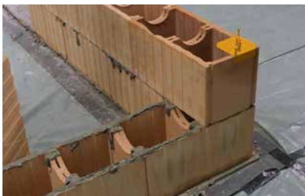
Mauern der Wanddecken im Verband
