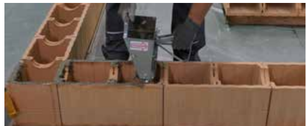
Auftrag von Dünnbettmörtel mit der Mörtelrolle
