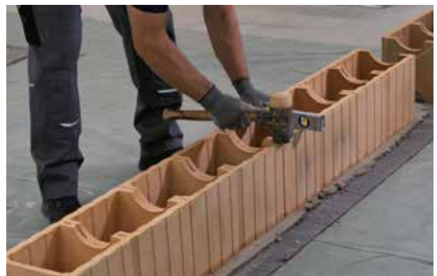
Lotrechtes setzen der Schalungsziegel mit gespannter Richtschnur
