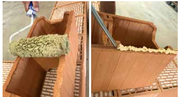
Verkleben der Schalungsziegel mit Dryfix Planziegelkleber, Auftrag auf den Außenlängsstegen
