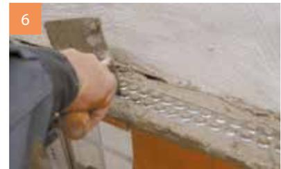
6 ... und ein Edelstahl-Lochband eingebettet. Das Lochband wird im Auflagerbereich über 3 Stege geführt.
