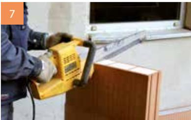
7 Passsteine mit geeignetem Werkzeug schneiden (WDF®-Ausgleichsziegel verwenden)
