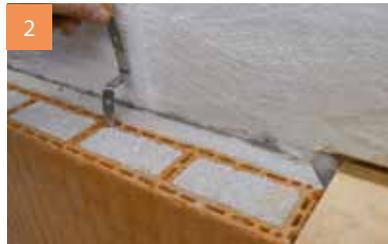
2 Rückverankerung mit abgewinkelten Flachstahlankern. Die Verankerung dient als Montagehilfe und wird nach der 2. Steinreihe und dann in jeder 3. Lagerfuge angeordnet. Der horizontale Abstand beträgt 1,5 m.
