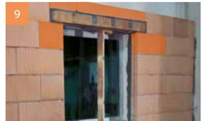
9 Fertigstellung der Innendämmung, WDF®-Ausgleichsziegel sind farbig hinterlegt
