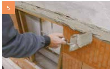
5 Diese Montageunterstützung dient auch zur Erstellung des Zuggurtes. Dazu wird ein Mörtelbett (z. B. dickflüssiger DBM) angelegt ...
