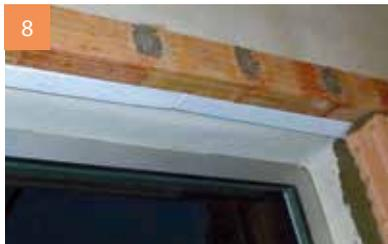
8 Sturzausbildung mit Ziegel-Flachsturz (hochkant) und rückseitiger Wärmedämmung oder Wärmedämmputz (alternativ mit Edelstahl-Lochband analog WDF®-80)
