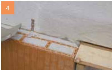
4 Die Auflagerlänge im Sturzbereich beträgt ca. 26 cm bzw. 3 Ziegelstege. An den Sturzenenden werden ganze WDF®-Ziegel angeordnet. Bis zum Aushärten des Mörtels wird eine Montageunterstützung angebracht.
