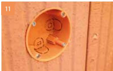
11 Elektroinstallation mit Leerrohren und Hohlraum Dosen
