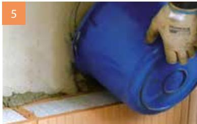
5 Hohlraumfreie Hinterfüllung mit Anlege- und Hinterfüllmörtel
