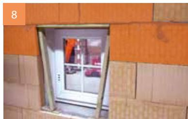
8 Fertige Sturzausbildung. Nach Aushärten des Mauermörtels kann die Montageunterstützung entfernt werden. WDF®-Ausgleichsziegel sind farbig hinterlegt.
