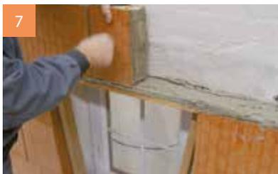
7 Außerdem werden die Stoßfugen der Ziegel in der Übermauerung vermörtelt
