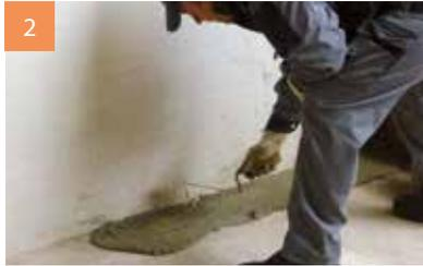
2 Höhengleich mit Anlege- und Hinterfüllmörtel auf Bodenplatte oder Geschossdecke
