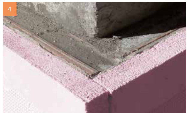
4 Die Konsolen werden mit Ziegelstürzen (115/113) überbrückt und anschließend gedämmt. Nach Auftrag einer Mörtelausgleichsschicht kann mit den Mauerarbeiten begonnen werden.
