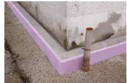
Fundament mit Perimeterdämmung
