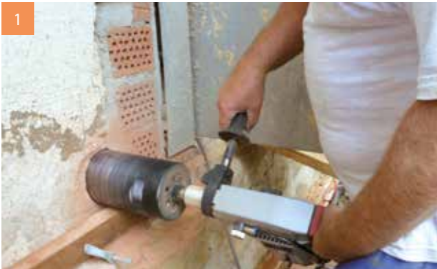
1 Erstellen des Bohrlochs (d = 125 mm) in der Bestandswand mit handgeführtem Bohrgerät. Zur Führung der Bohrkronen wird vorher eine Schablone angebracht.
