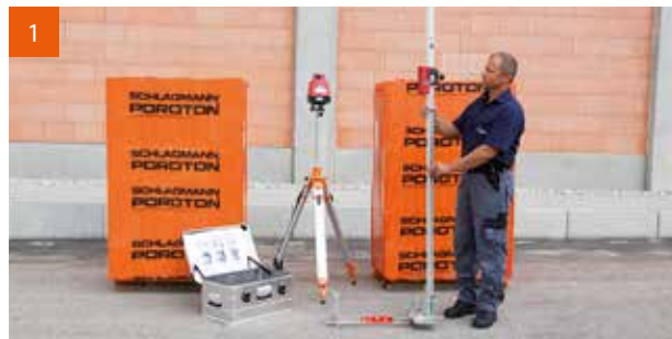
1 Ausgleichsschicht: Mit dem Nivelliermax und Laser wird der höchste Punkt auf der Rohdecke ermittelt und in Wandbreite eine Bitumenbahn aufgelegt.
