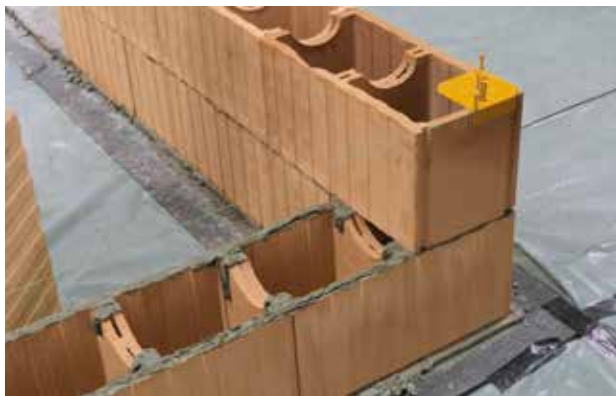
Mauern der Wanddecken im Verband
