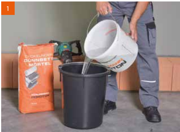
1 Erst das Wasser in den Mischeimer füllen ...
