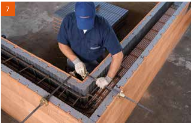
7 Erforderliche Bewehrung nach Angabe Statik einlegen und Schalungsanker zur Sicherung gegen Betondruck anbringen.
