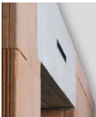
Im Kasten vormontierter Luftdurchlassschlitz
