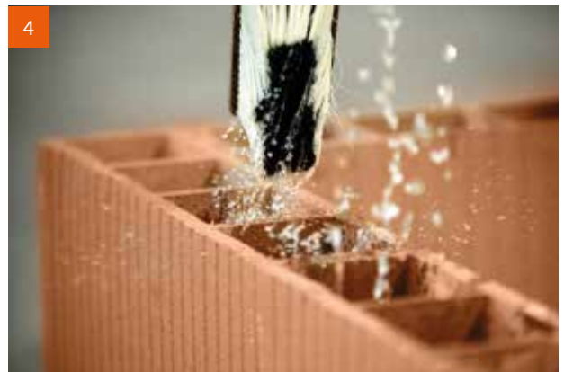
4 Vor dem Verfüllen werden die Kammern der Ziegel vorgeenässt.
