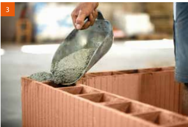
3 Die Ziegel werden schichtweise mit Mörtel oder Zementstrich verfüllt.
