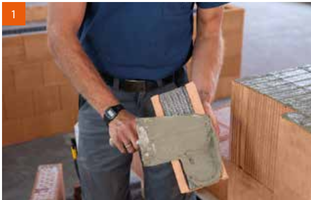
1 Satter Mörtelauftrag auf die Ziegelstege der AnschlagSchale.
