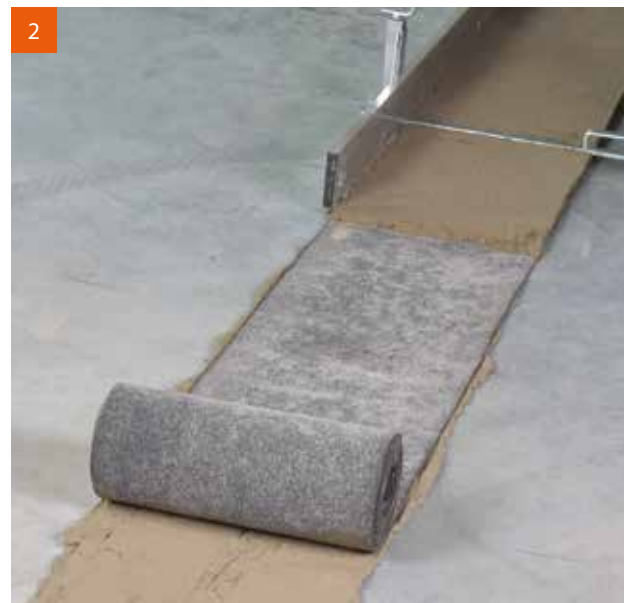
Einlegen einer Querschnittsabdichtung aus besandeter Bitumenbahn R 500.
