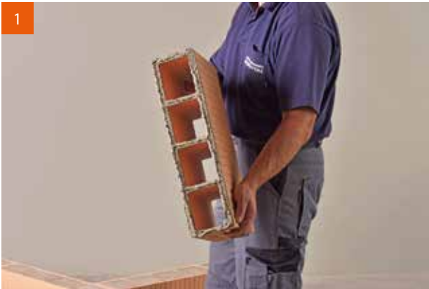
1 Der Dünnbettmörtelauftrag auf den Planziegel Pz-I-115 erfolgt wahlweise durch Tauchen oder ...
