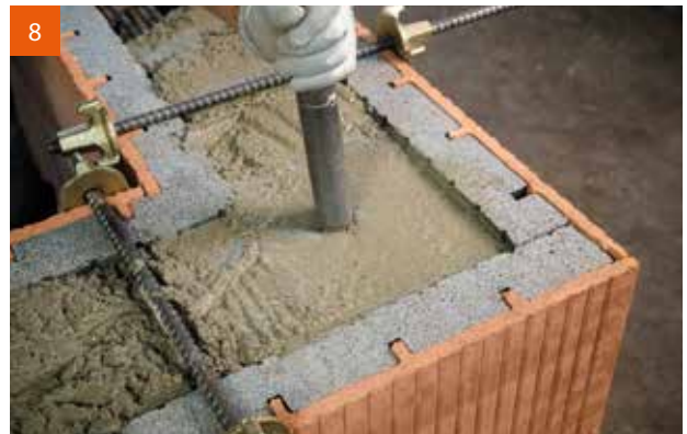
8 Ausbetonieren des Ringbalkens und Verdichten des Betons.
