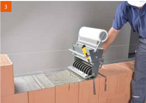
Anschließend wird der Mörtel über die Flachstahlanker gerollt.
