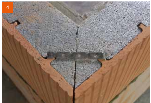
4 Ggf. Montageunterstützung mit Flachstahllanker über Eck.
