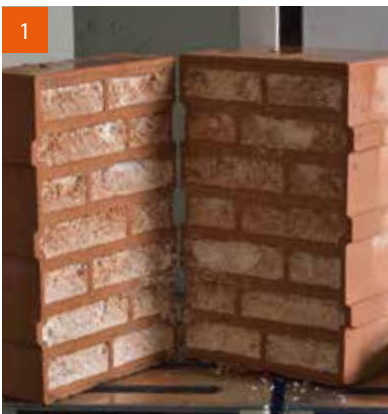
Höhenausgleich: Ausgleichsziegel mit der Nasssäge schneiden.
