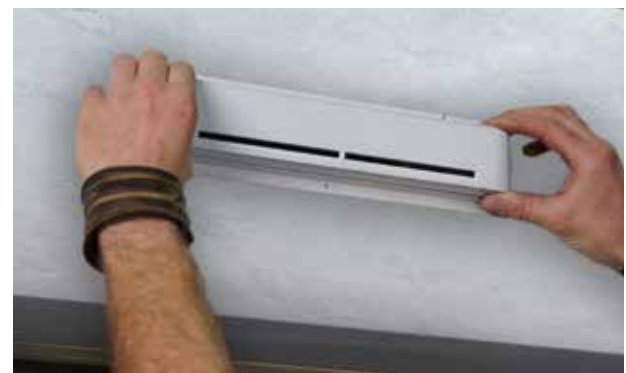
Von Aereco: Feuchtegeführter Außenbauteil-Luftdurchlass ZUROH 100 / 110 als Nachströmelement für Abluftanlagen, Montage nach dem Verputzen
