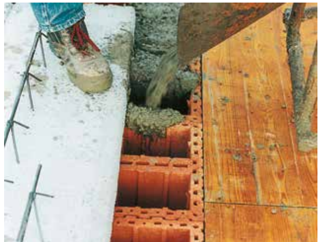
Verfüllung mit fließfähigem Normalbeton
