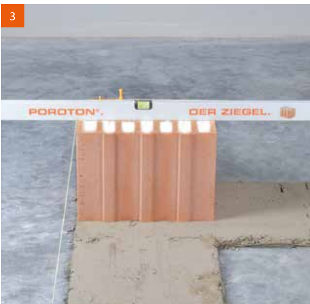
Lotgerechtes Setzen des ersten Ziegels mit gespannter Richtschnur.
