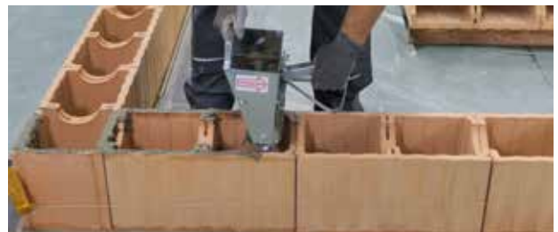
Auftrag von Dünnbettmörtel mit der Mörtelrolle
