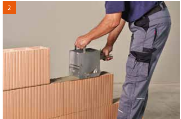
2 ... mit dem WDF-120 Mörtelschlitten. Alternativ können die Ziegel auch mit dem POROTON® Dryfix-Kleber verklebt werden.
