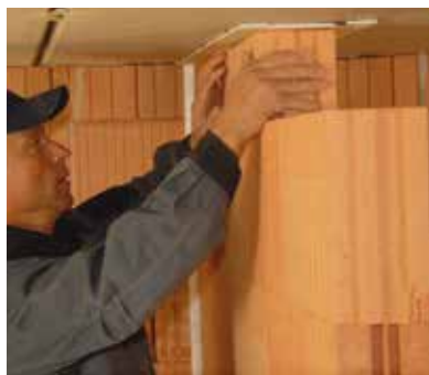
Anschließen des Deckenprofils: Aufmauern der restlichen Ziegellagen und Verschließen der Fuge zur Decke mit Mörtel.
