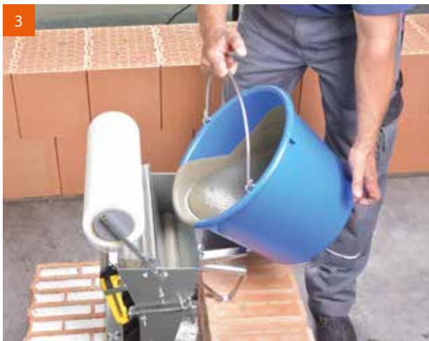
3 Befüllen der V.Plus®-Walze mit Dünnbettmörtel.
