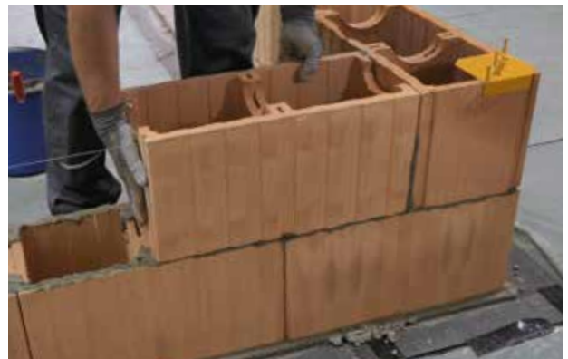
Stumpf gestoßene Ziegel im Eck stirnseitig mit Dünnbettmörtel verkleben
