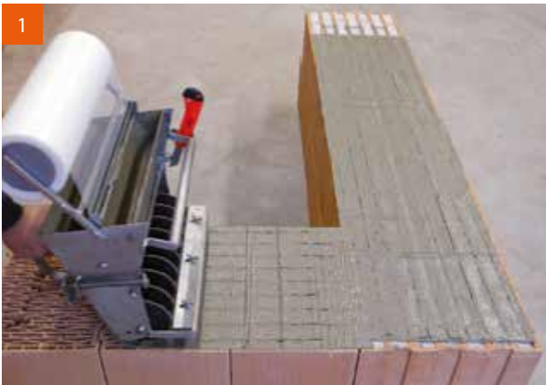
1 Auftrag des Dünnbettmörtels auf die Mauerkrone.
