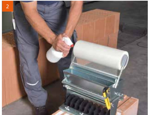
2 Die V.Plus®-Walze vor dem Befüllen mit Trennmittel (Schalöl) einsprühen. Das erleichtert die spätere Reinigung.
