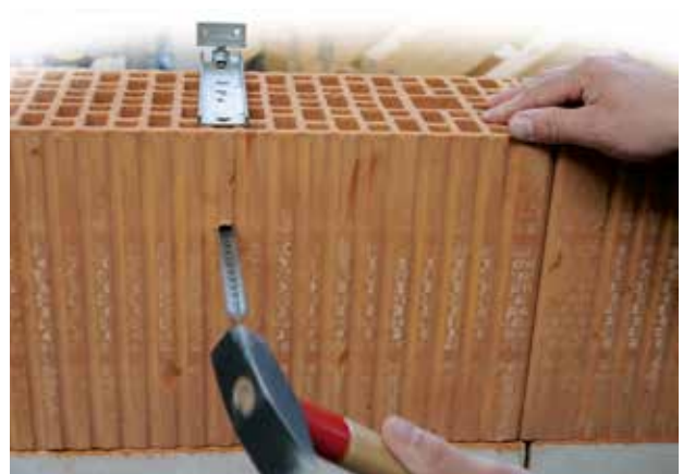
Fensterverschraubung im Brüstungsbereich mit V-Lochschiene
