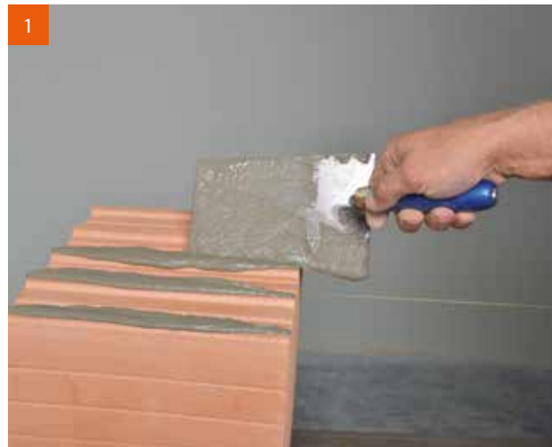
Auftrag von Dünnbettmörtel auf die Stoßfuge.
