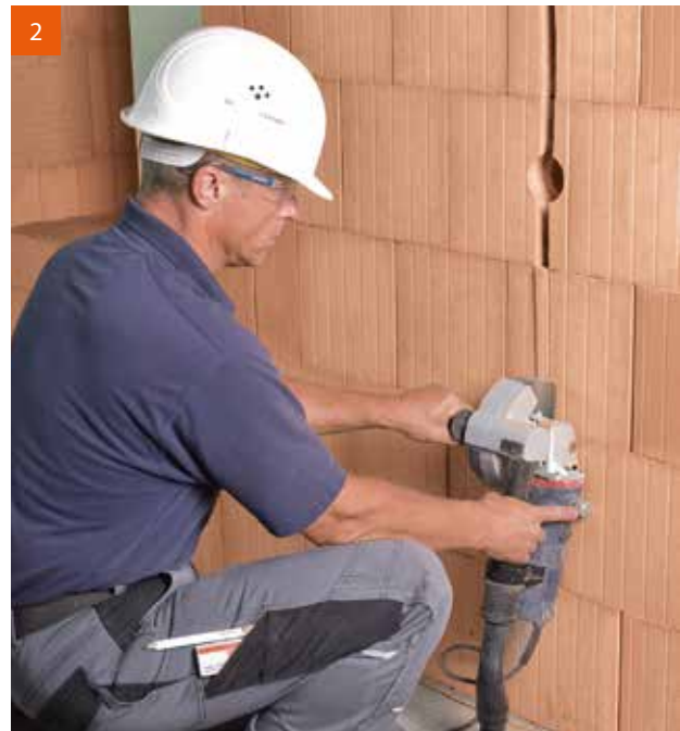
Erstellung der Schlitze mit einer Mauernutsäge.
