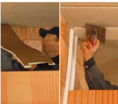
Anlegen des Deckenprofils: Das Deckenprofil an der Oberseite über die ganze Bahn mit Dünnbettmörtel oder Silikon bestreichen.
