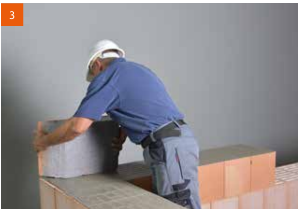
3 POROTON®-DRS® in das frische Mörtelbett setzen.
