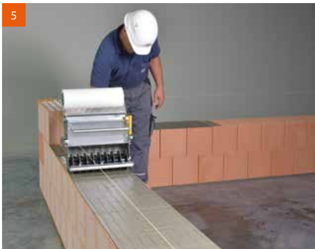
5 Walzen im Schritttempo und Versetzen gleichzeitig.
