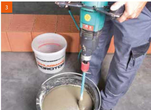
3 Der Dünnbettmörtel wird idealerweise mit einem leistungsfähigen Rührgerät...
