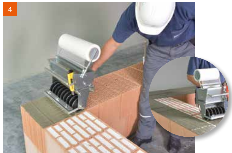
4 Ansetzen mit der V.Plus®-Walze im Eckbereich. Bei Wandstärke 49 cm erfolgt der V.Plus®-Mörtelauftrag in zwei Arbeitsschritten mit 2 x 24 cm V.Plus®-System.
