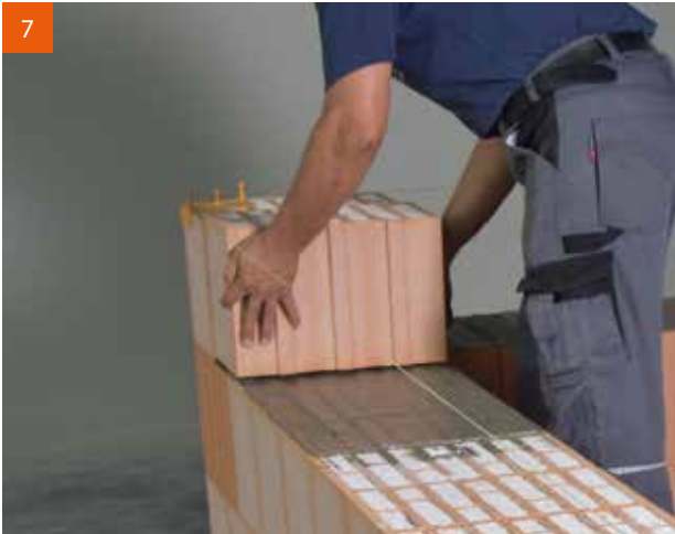
7 Einfaches knirsches Versetzen des POROTON®-Planziegels.
