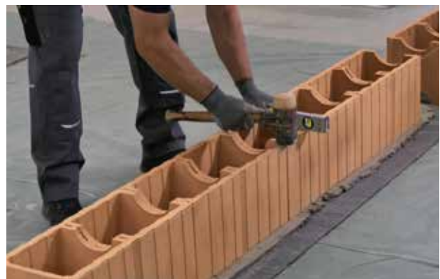
Lotrechtes Setzen der Schalungsziegel mit gespannter Richtschnur
