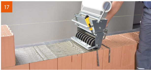
17 Anschließend wird der Mörtel über die Flachstahllanker gerollt.
