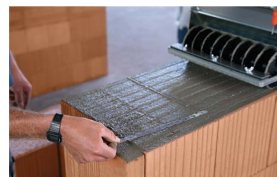
Ggf. zusätzliche Lagesicherung mit Flachstahllanker.
