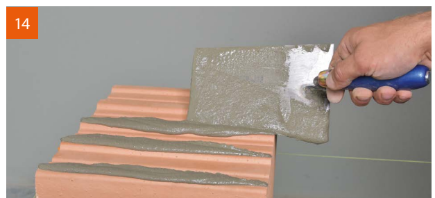
14 Eckanschluss: Mörtelauftrag auf die Verzahnung.
