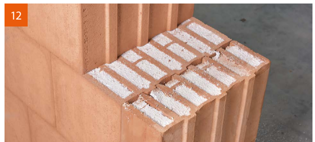
12 Der Ausgleichsziegel ist wärmebrückenfrei versetzt.
