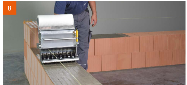
8 Walzen im Schritttempo und Versetzen gleichzeitig.
