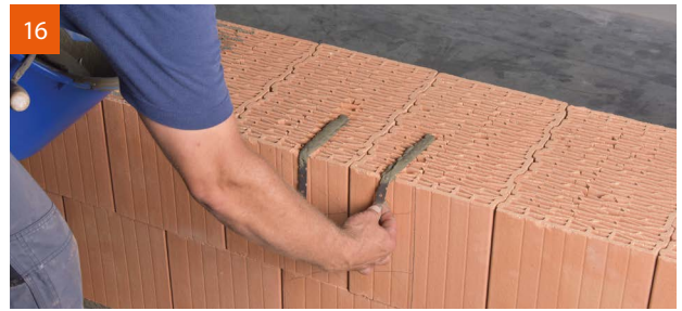
16 Einsetzen der in Dünnbettmörtel eingetauchten Flachstahllanker. Um Verletzungen vorzubeugen, werden die Anker umgebogen eingesetzt.
