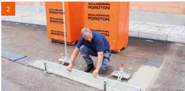
Abziehen: Ausgehend vom höchsten Punkt wird ein ca. 1,5 cm dickes vollflächiges Mörtelbett für die erste Ziegelschar angelegt. Der Nivelliermax ermöglicht ein millimetergenaues Abziehen des Mörtelbettes mit der Messlatte.
