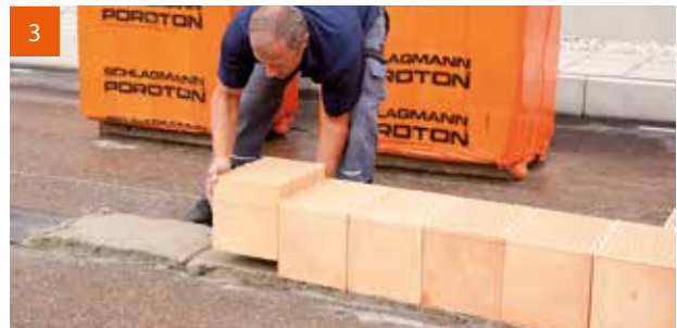
Erste Ziegelschar: In das noch feuchte Mörtelbett wird die erste Ziegelschar versetzt und ausgerichtet. Das exakte Einrichten der ersten Ziegelschar auf Ebenflächigkeit ist mit größter Sorgfalt durchzuführen und durch Auflegen einer 3–4 m langen Alulatte zu überprüfen und ggf. zu korrigieren.
