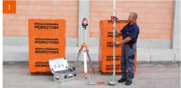
Ausgleichsschicht: Mit dem Nivelliermax und Laser wird der höchste Punkt auf der Rohdecke ermittelt und in Wandbreite eine Bitumenbahn aufgelegt.
