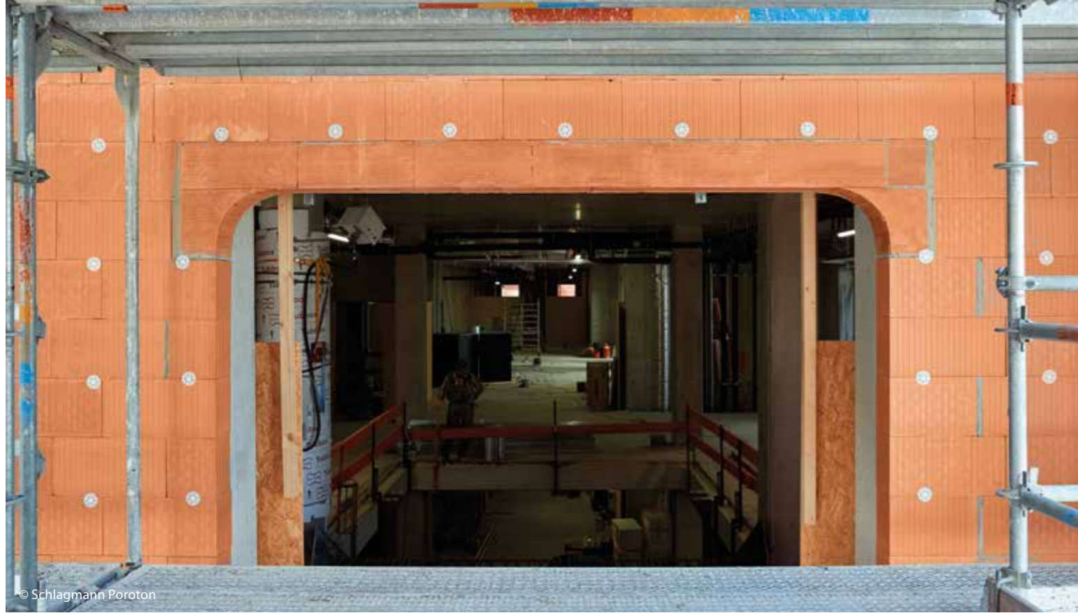
^ Zwei verschiedene Sonderbauteile: Rundbogen und Sturz mit seitlicher Ausrundung.
