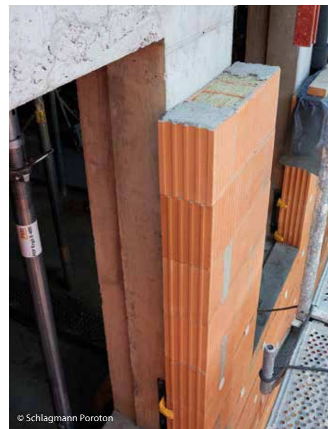
< Der Wandaufbau aus Stahlbeton und WDF, hier: ein vorbereitetes Auflager für den WDF-Rundbogen.
