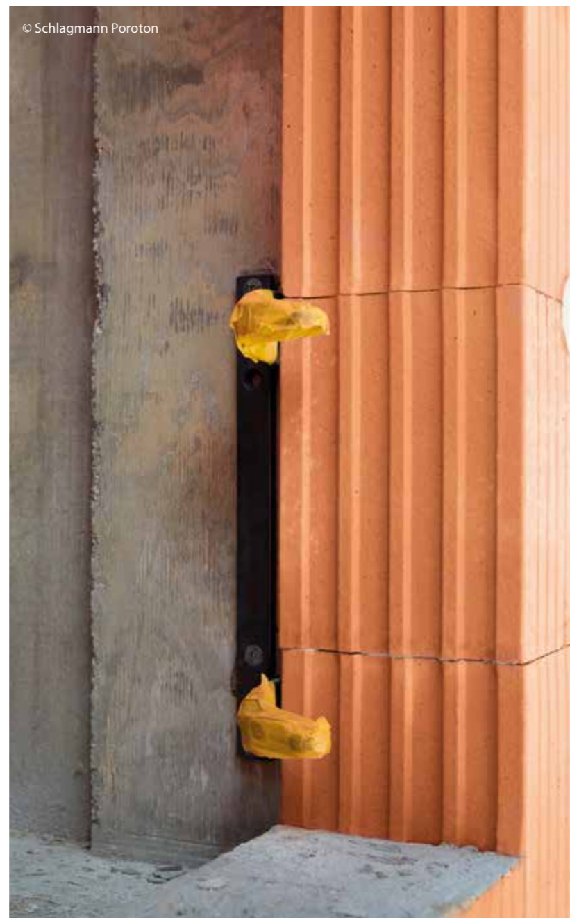
> Ein gut durchdachter Wandaufbau: innen Stahlbeton, außen die WDF. Und dazwischen die Unterkonstruktion für die Absturzsicherung; sie wurde am Beton befestigt.
