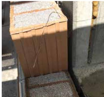
Kleines Bild links: Die massive Dämmung Poroton-WDF ist schon auf halbem Weg nach oben.
