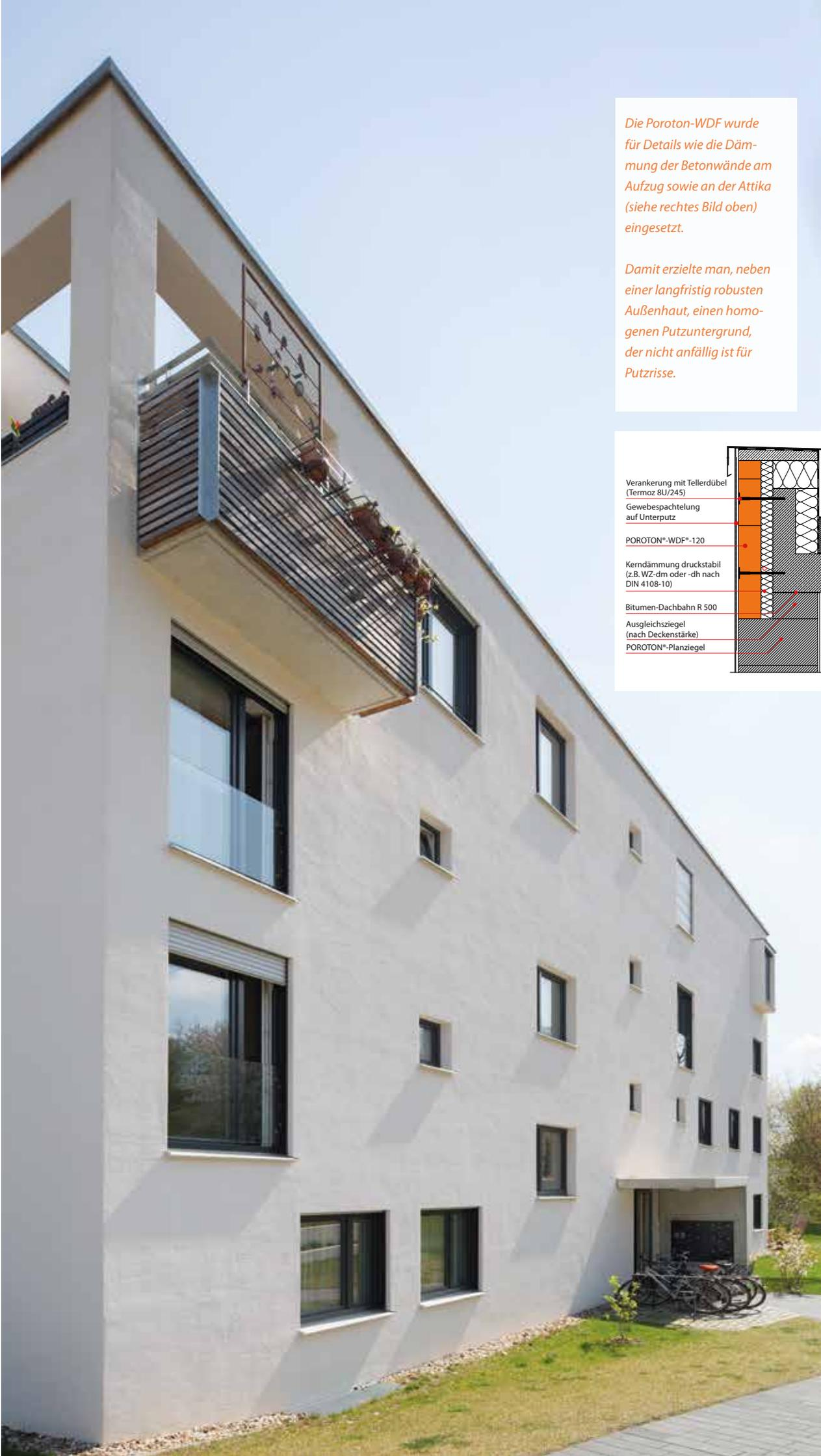
Die Poroton-WDF wurde für Details wie die Dämmung der Betonwände am Aufzug sowie an der Attika (siehe rechtes Bild oben) eingesetzt.
