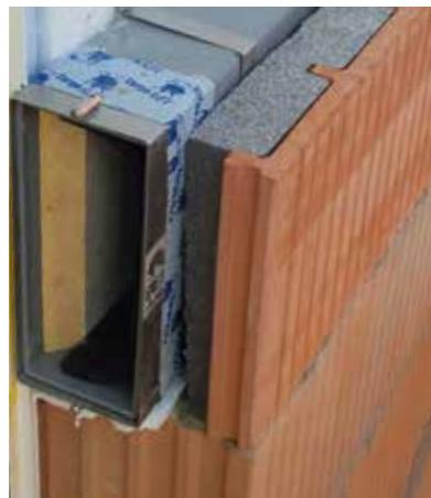
Bild oben: Detail vom Einbau der Lüftung in der Dämmebene (Laibungsvariante);
