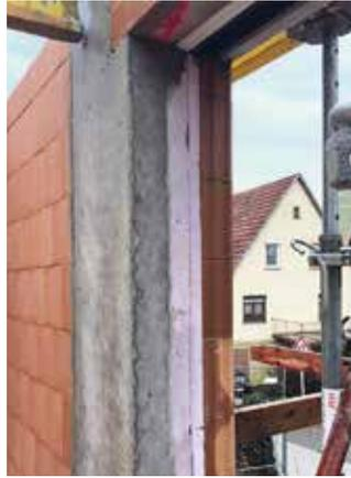
Am Objekt kamen interessante WDF-Details zum Einsatz: die Deckenrandschale Plus als Giebelgurt (Bilder oben), die Verarbeitung der WDF und der Deckenrandschale Plus am Erker (ganz links) sowie vor den zwei Stahlbetonstützen im weit gespannten Eingangsbereich (links). Ab dem Erdgeschoss sind keine Betonbauteile mehr ersichtlich und die Gebäude sind bestens gerüstet für die Lage im Erdbebengebiet EB 2.
