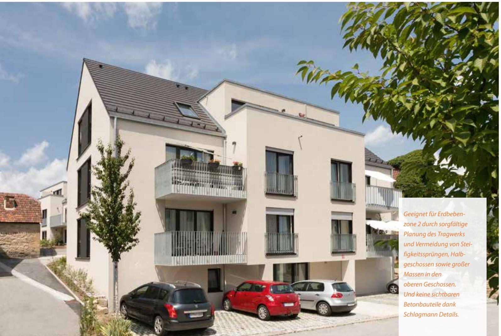
*Geeignet für Erdbebenzone 2 durch sorgfältige Planung des Tragwerks und Vermeidung von Steifigkeitssprüngen, Halbgeschossen sowie großer Massen in den oberen Geschossen. Und keine sichtbaren Betonbauteile dank Schlagmann Details.*
