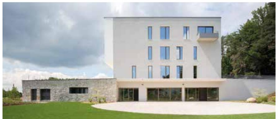
*Bei einem Gebäude dieser Größe vermuten die meisten automatisch Betonwände. Doch hier sind die Außenmauern aus massiven perlitgefüllten Ziegeln*
