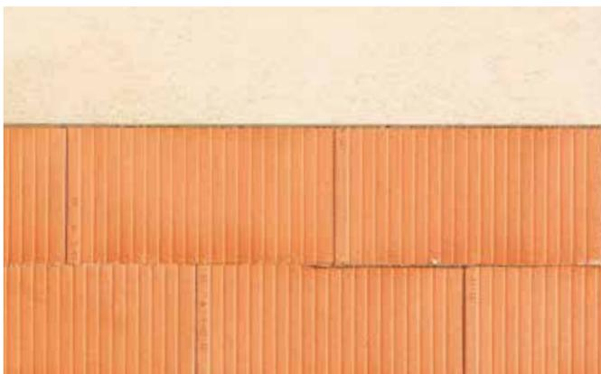
Bilder oben: Zu Beginn der Sanierungsarbeiten wurde die Poroton-WDF in 18 Zentimeter Stärke vorgemauert.
