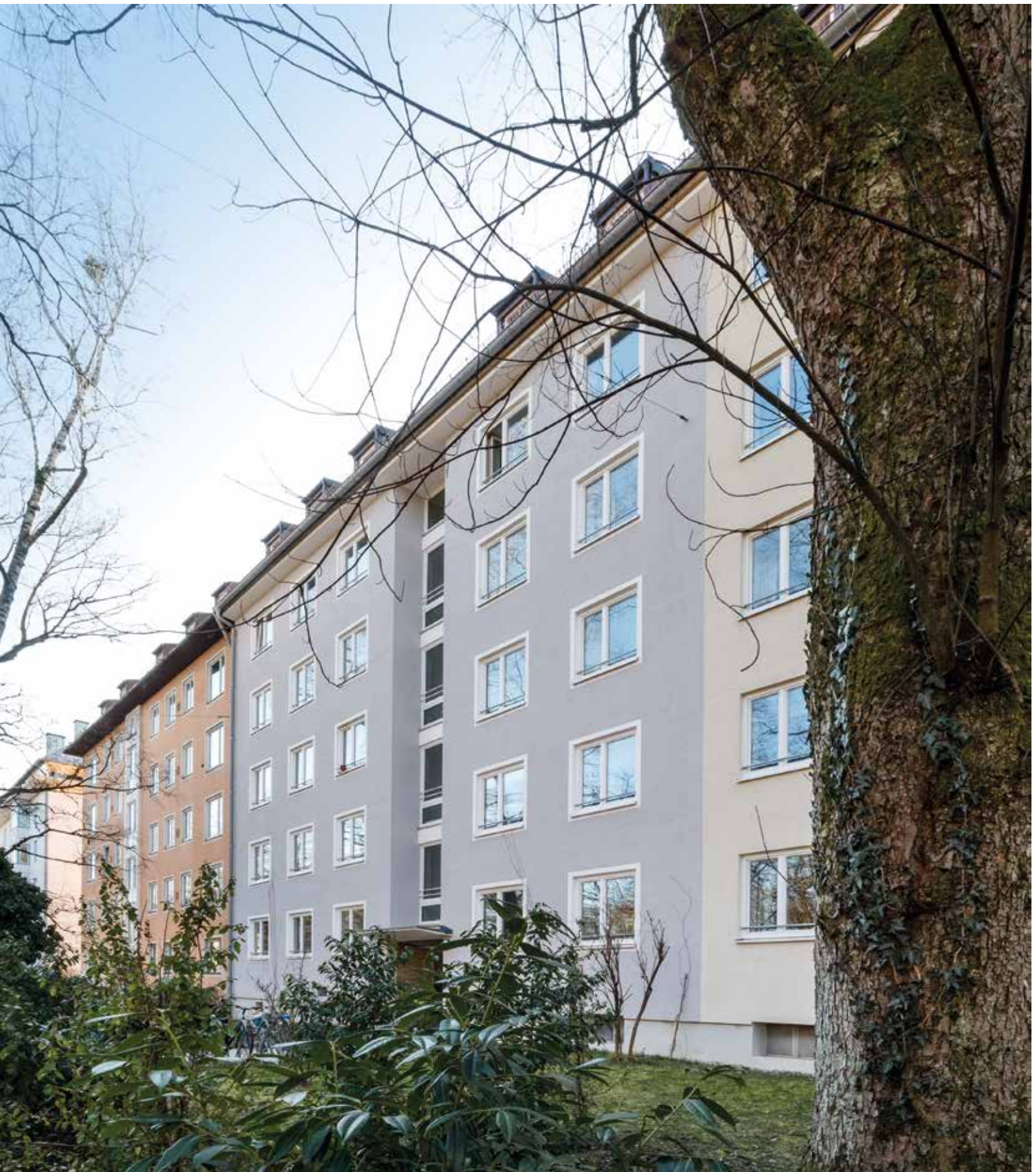
Der Wunsch der Architekten war es, dass die gedämmte Fassade der ursprünglichen gleicht. Die Fenster schließen bündig mit dieser ab. Ein Detail, das sich mit der WDF leicht realisieren lässt.
