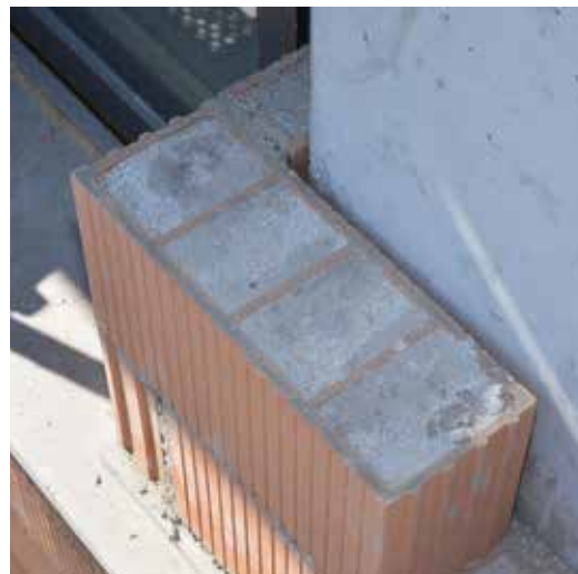
Die Poroton-WDF ist im Vergleich zu herkömmlichen Dämmsystemen im Vorteil durch eine robuste, langlebige Konstruktion sowie niedrigere Instandhaltungskosten. So entstand auch ein einheitlicher, sauberer Putzgrund.
