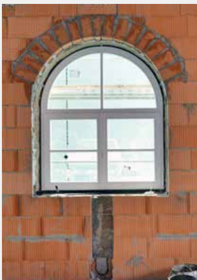
Detail Bogenfenster | Objekt Wohnhaus Straubing | Seite 46 – 51: Abbildung links; Fenstersturz WDF-80 | Die Erstellung des Fenstersturzes erfolgt bei Poroton-WDF-80 mit WDF-Ausgleichsziegel und Edelstahl-Lochband.
