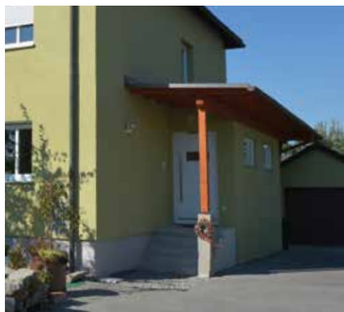
Massiv gedämmte Fassade und Keller, ausgetauschte Fenster und Türen.
