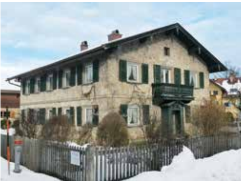
Bild oben: Neu angebaut wurde ein Treppenhaus zur Erschließung der vier Wohneinheiten. Auch hier ließ man charakteristische Einblicke auf die Natursteinwand.
