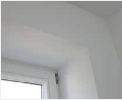
Fensterlaibung | Objekt Fasangarten | Seite 36 – 39 | Hier kam die NEU entwickelte Poroton-WDF-80 als Innendämmung zum Einsatz. Eine Besonderheit war ein innen angebrachter Dämmputz – hier an der Fensterlaibung.
