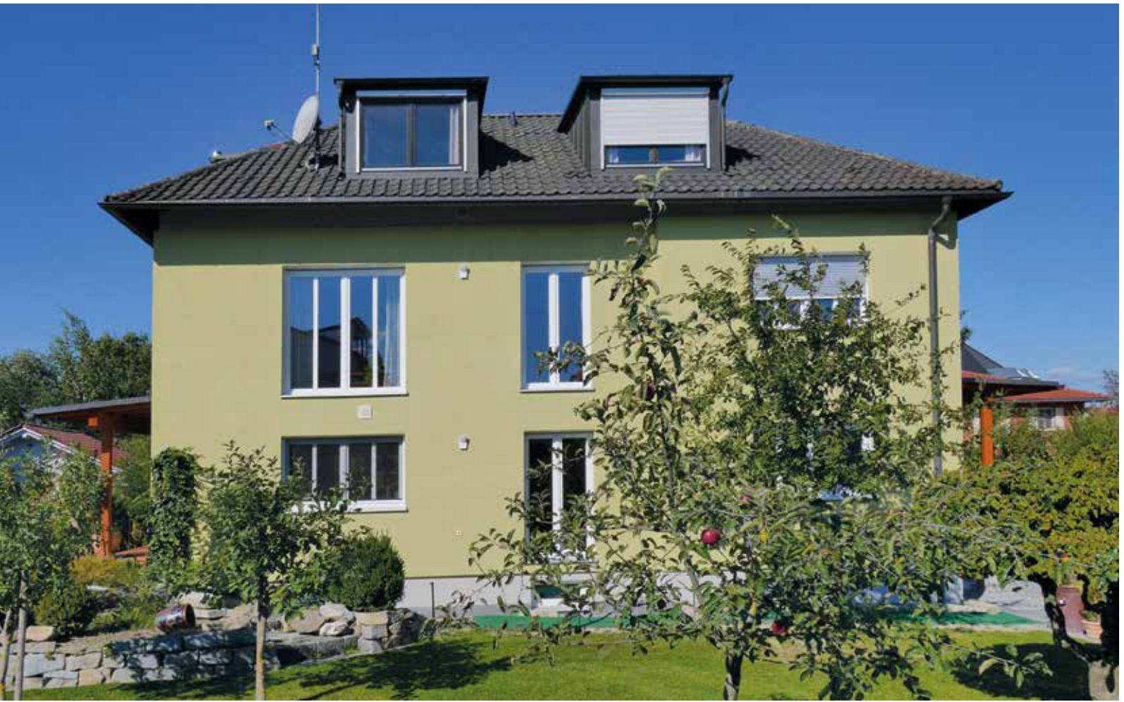
Wo vorher nur der Wunsch war, das 60 Jahre alte Zweifamilienhaus zu sanieren, machte dies schließlich das schwere Hochwasser von 2013 unumgänglich. Die Generalsanierung machte aus dem Ziegelhaus wieder ein kleines, dabei energiesparendes Schmuckstück.
