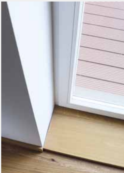
Bodenanschluss | Objekt Fasangarten | Die Bestandswand wurde abgedichtet sowie unter der WDF-Innendämmung eine Horizontalsperre eingezogen.
