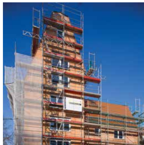
Der Rohbau lässt bereits gut die Form des Peters-tors erkennen.
