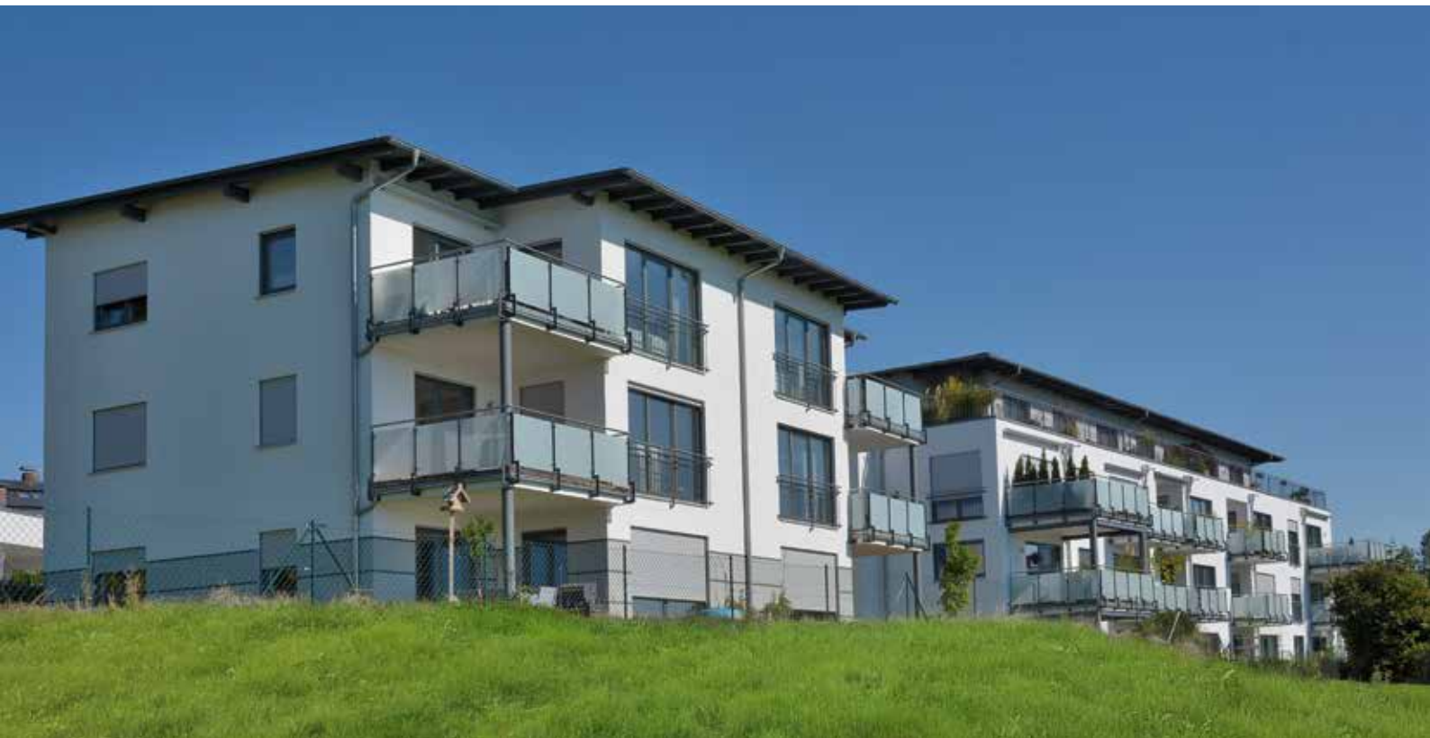
23 Wohneinheiten in zwei recht unterschiedlich dimensionierten Baukörpern entstanden hier neu in Deggendorf – ruhig, in Gehweite zur Donau und doch nah am Zentrum der aufstrebenden Wirtschafts- und Hochschulstadt.
