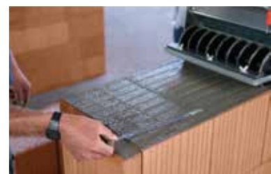
Ggf. zusätzliche Lagesicherung mit Flachstahllanker.
